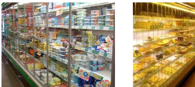
Dispositifs de fermetures non hermétiques pour des meubles de vente verticaux à froid positif. (Source : Energie+)
